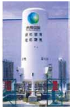
合成空気用液化ガス貯槽
